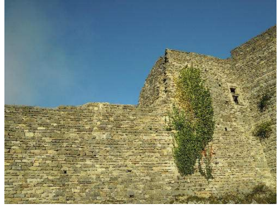
état actuel de la façade sud de la cuisine
