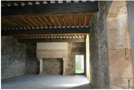
Une salle, restaurée ;
