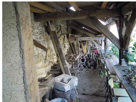
état actuel des ateliers sous les appentis
